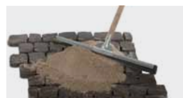
Einarbeiten mit Gummischieber
